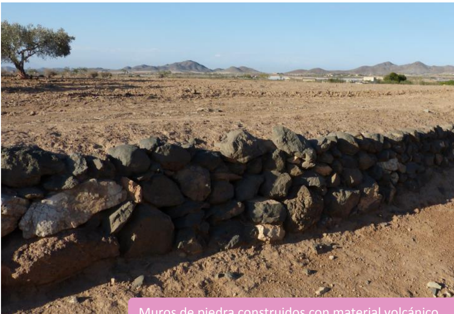
Muros de piedra contruidos con material volcánico
